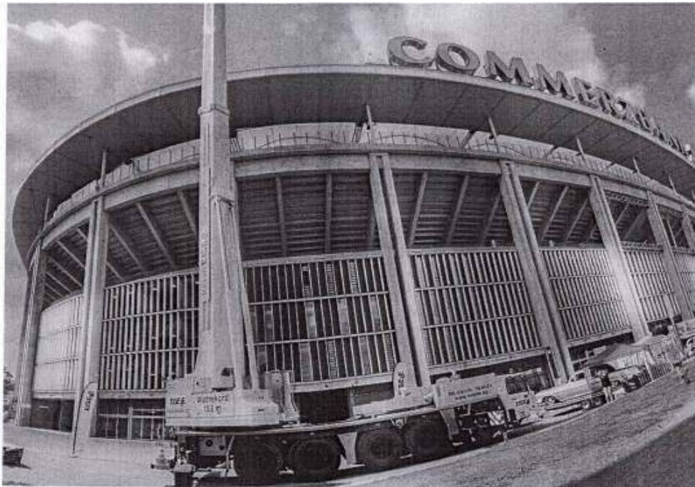
Um Aufnahmen auch aus großer Höhe machen zu können, stellten GL Verleih Arbeitsbühnen und Eisele Crane & Engineering Group in bewährter Kooperation eine 70 m hohe Hubarbeitsbühne WT 700 für die Dreharbeiten bereit. Foto: Uli Planz
